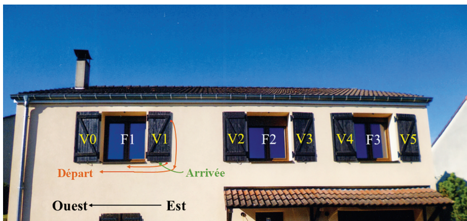
Figure 2. Vantoux (57) – Façade de la maison avec les gîtes d'accueil des Pipistrelles (49°07'49.7"N 6°14'14.6"E, 2021-2024)
