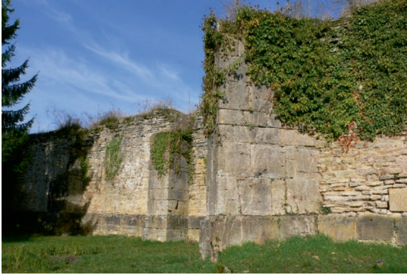
Figure 1 – Abbatale de Villers-Bettlach, mur sud : deux assises inférieures et contreforts en grand appareil, moellons en plaquettes de calcaire siliceux.
